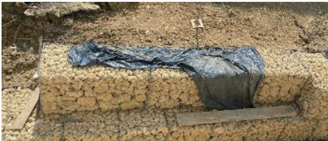
Inicio de obras muro de contención. Diciembre 2024
